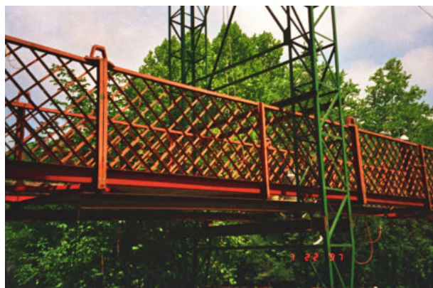
Fig. 17 - Passerella Goito- Impalcato con attrezzature provvisorie per stabilizzare la stilata e per l'appoggio sul sistema di travi inferiori
