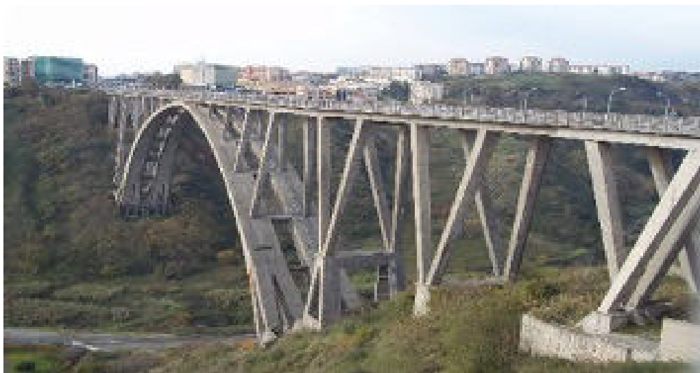
Fig. 8. Ponte sul torrente Fiumarella a Catanzaro. Immagine tratta dal web.
