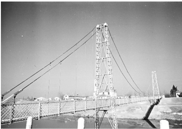
Fig. 2 - La passerella Benetti appena costruita nel 1956
