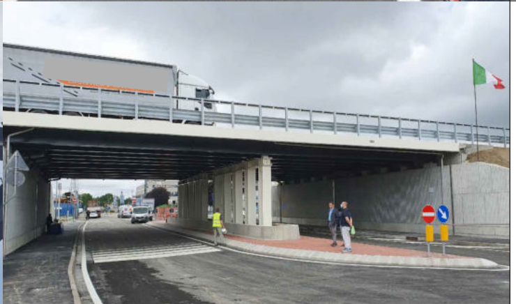
VIADOTTO TANGENZIALE EST PADOVA
