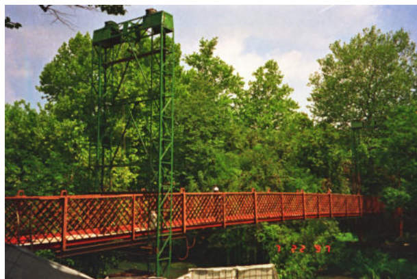
Fig. 16 - Passerella Goito - La passerella priva di pendini e funi portanti in appoggio sulle strutture provvisorie
