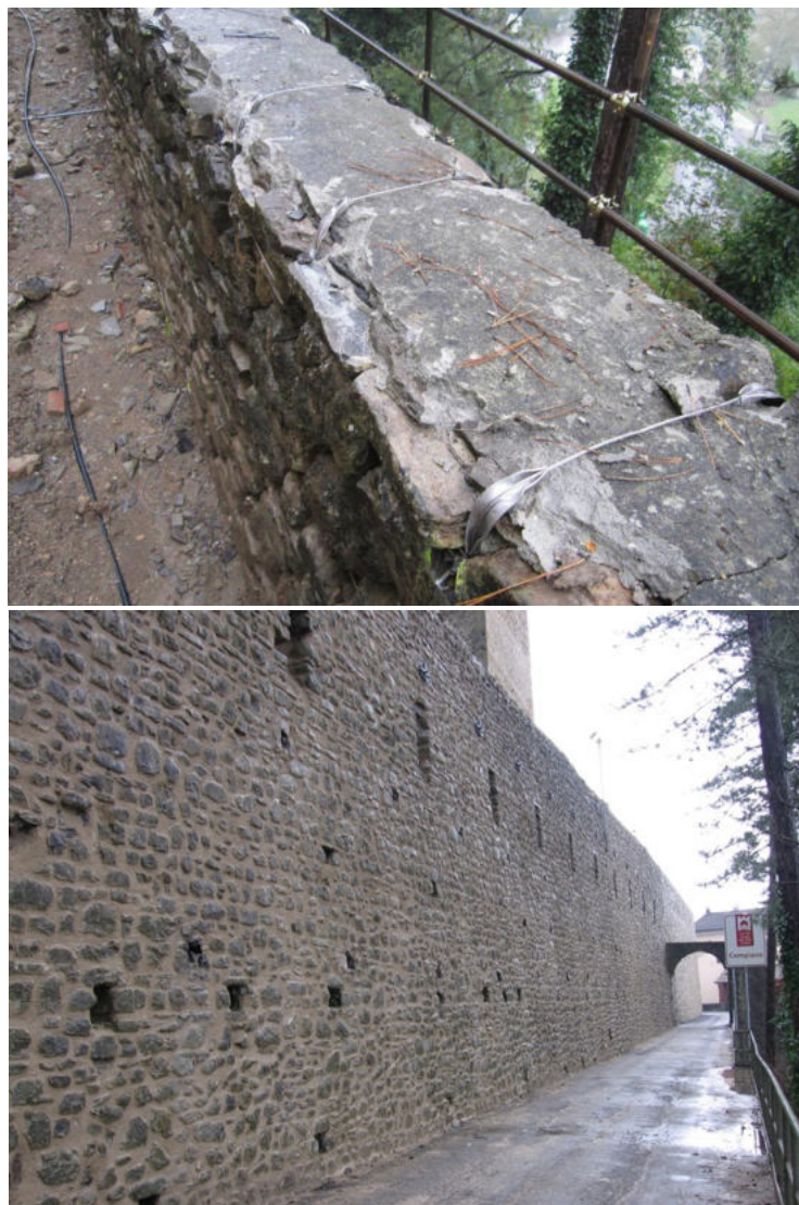
Figura 4. Intervento con la tecnica del Reticolatus sulle mura di cinta del Castello di Compiano (PR).
