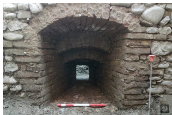
Fig. 4 - La bombardiera del vano seminterrato a sud della torre portaia (© Sabap-RA).
