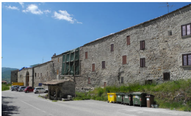
Fig. 3 -Norcia, la cinta muraria con innumerevoli aperture realizzate dopo di addossamenti di abitazioni e crollo di una porzione della struttura a seguito del terremoto del 2016.
