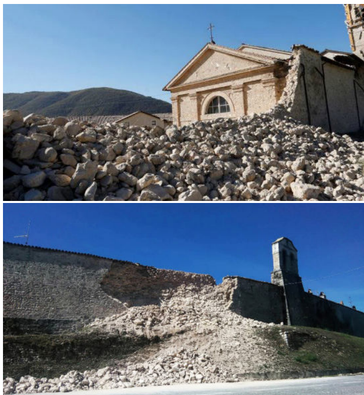
Figura 1. Crolli che hanno interessato le mura del centro storico di Norcia (PG) nel sisma del 2016.
