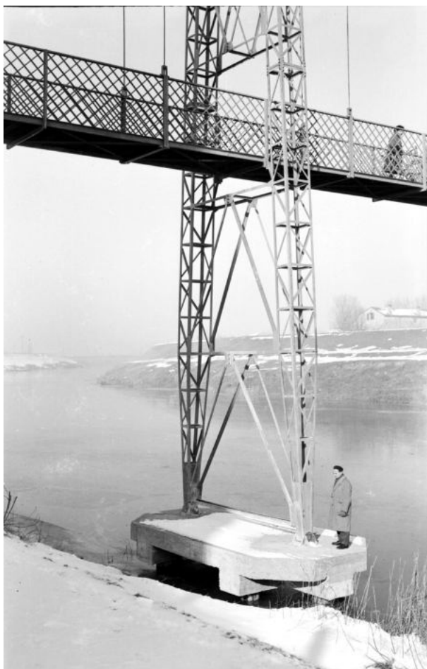
Fig. 1 - Passerella Benetti - La cerniera alla base della stilata
