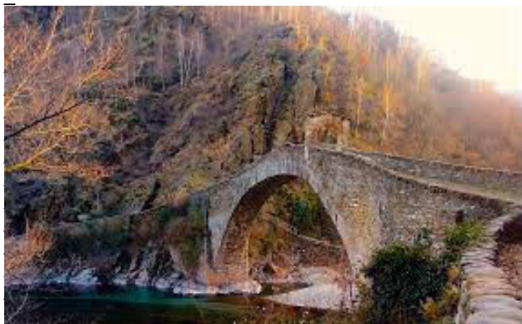
Fig. 11 - Il Ponte del Rock a Lanzo
