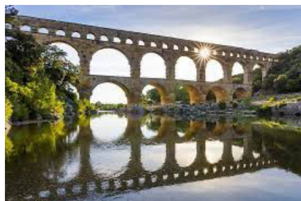
Fig. 8 - Il pont du Gard (17 a. C.)
