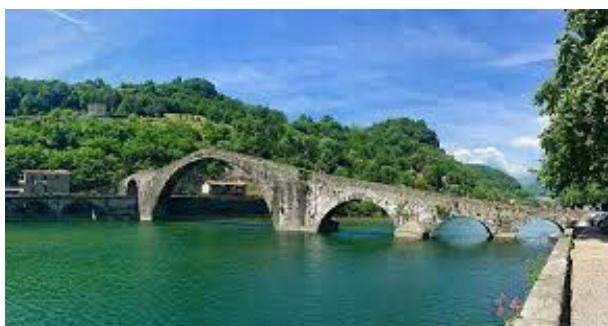
Fig. 10 -Il ponte della Maddalena (1000)
