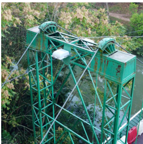
Fig. 2 - Passerella Goito - Selle in acciaio fuso per l'alloggiamento delle funi portanti
