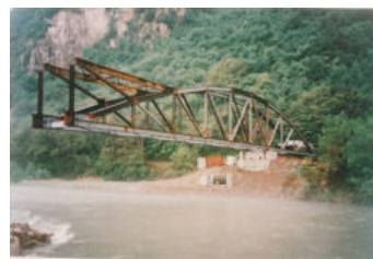
Fig. 2 - Il varo nella nuova posizione: fase con ponte risanato equipaggiato con le strutture provvisorie per il collegamento dell'avambecco a sbalzo sull'Adige
