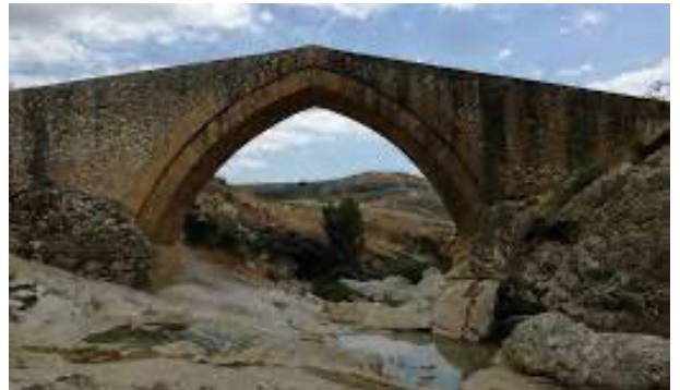
Fig. 18 -Il ponte di Calatrasi
