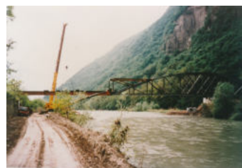
Fig.3 - Durante il montaggio dell'avambecco al ponte necessario per completare il varo
