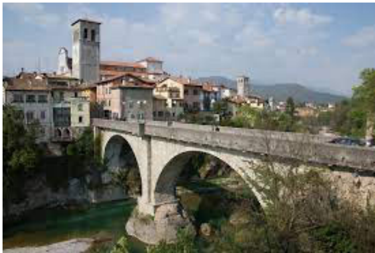
Fig. 14 - Il ponte di Cividale del Friuli (1442 -1501)
