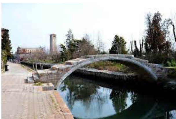
Fig. 22 - Il ponte nell’isola di Torcello (secolo XV)
