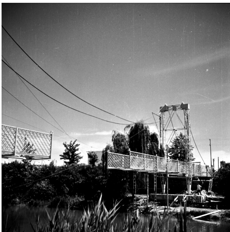
Fig. 3 - Passerella Goito - La trave reticolare con funzione di parapetto durante il montaggio della passerella
