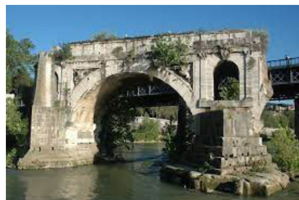
Fig. 2. Il ponte Emilio (III sec a. C.)
