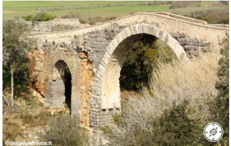
Fig. 4 - Il ponte di Vulci (epoca etrusca)
