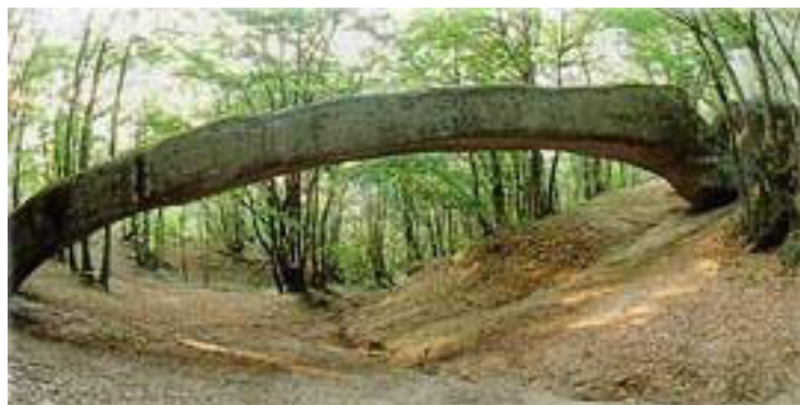
Fig. 23 - Il ponte di Pavullo
