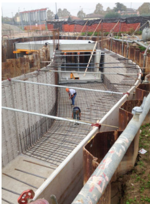
Fig. 3 – Lavori di realizzazione dello scolmatore di piena Limenella – Fossetta
