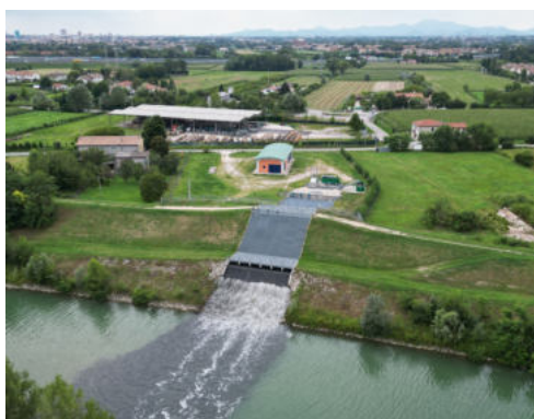
Fig. 4 – Impianto idrovoro di scarico in Brenta dello scolmatore di piena Limenella – Fossetta
