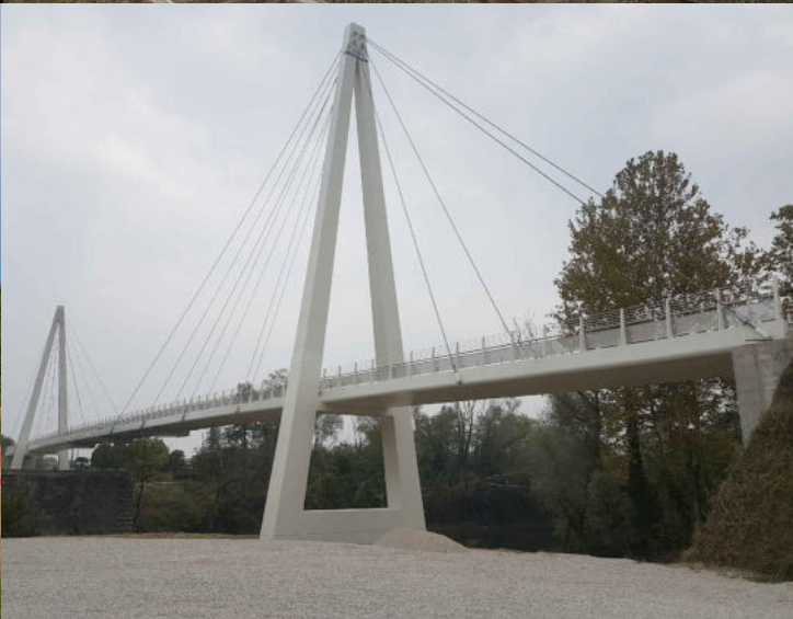
PASSERELLA STRALLATA SUL BRENTA
