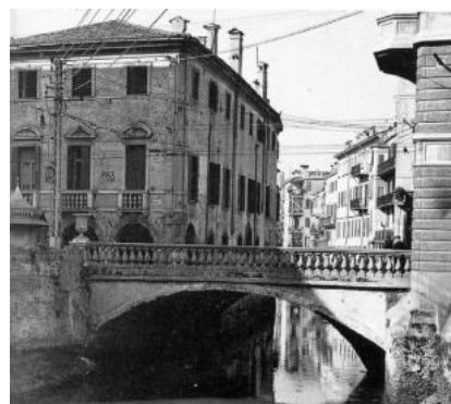
Fig. 1 - Il ponte delle Torricelle prima dell'interramento del Naviglio Interno
