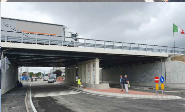
VIADOTTO TANGENZIALE EST PADOVA
