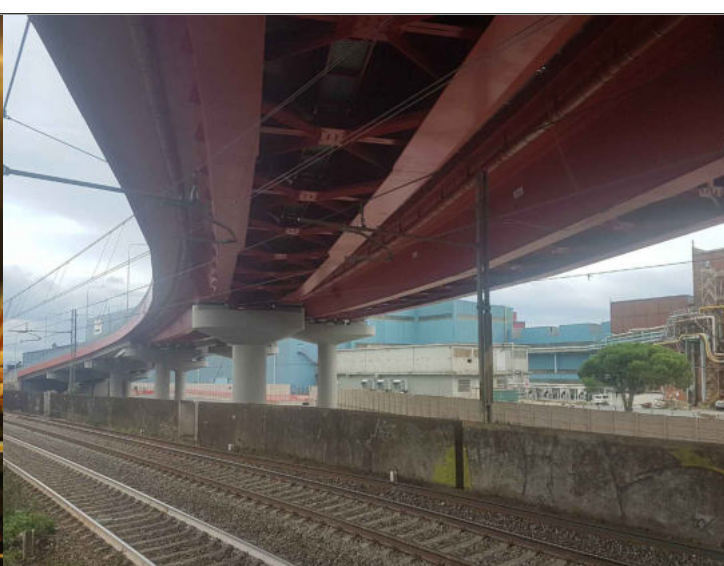
VIADOTTO STRADA A MARE GENOVA
