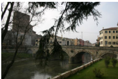
Porta Ponte Molino
