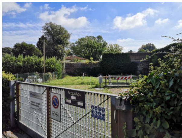
Figg. 13 -14 – Parco delle Mura – recinti chiusi e segnaletica del tutto noncuranti degli aspetti paesaggistici e naturalistici del Parco: impianto AcegasAPS in via Cernaia (torrione Ghirlanda) e impianto AcegasAPS in via Volturmo (baluardo S. Prosdocimo)
