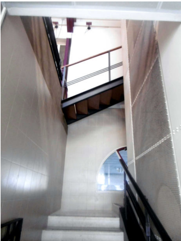
Fig. 10 - Scala tra piano terra e primo nel corpo principale
