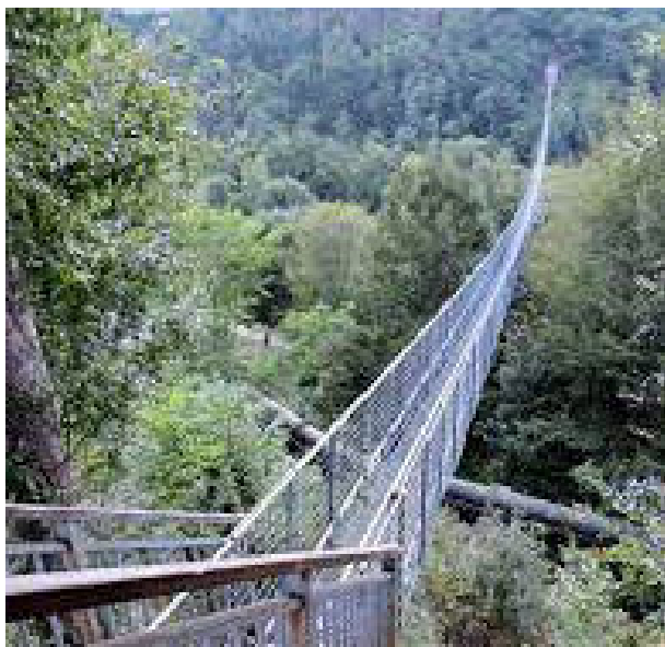
Fig. 19. Il ponte delle Ferriere (Toscana)
