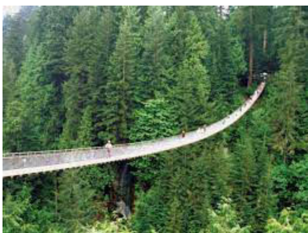
Fig. 28. Il Capilano Suspension Bridge (Canada)
