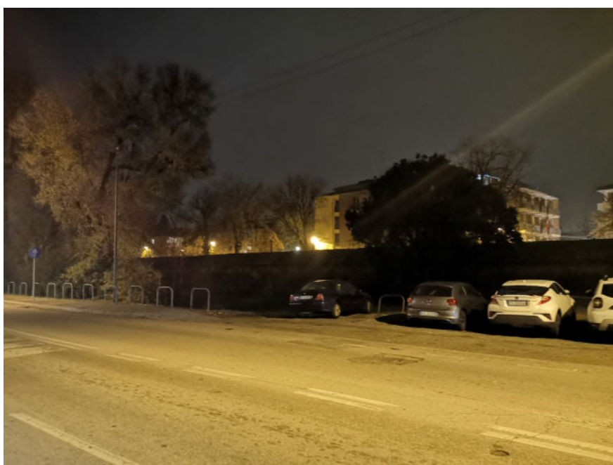
Fig. 18 – < 12. - Settore Nord-Ovest, vista dalla circonvallazione di via Bronzetti in prossimità di Porta Savonarola. Anche qui le Mura appaiono come una fascia nera tra le luci della strada e quelle degli edifici che sorgono subito a ridosso della cinta.
