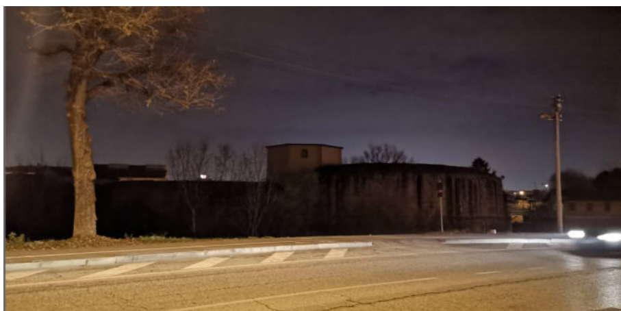
Fig. 12 – < 6. – La chiusa delle Gradelle (al termine del canale di S. Massimo) e il torrione Buovo, sagoma scura sullo sfondo delle luci della città, riflesse dal cielo. Fotografia sovraesposta. Nella realtà, tra i fari della strada, la sagoma appare completamente nera
