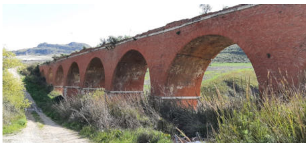
Fig. 2 - Naro ponte a nove luci
