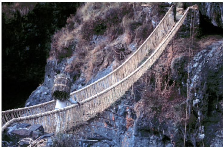
Fig. 2. Il ponte Qeswachka (Perù)
