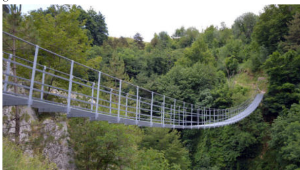
Fig. 21. Il ponte di Roccamaldolfi (Molise)
