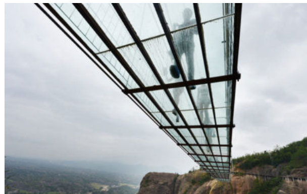
Fig. 25. Il ponte di Shiniuizhai (Cina)
