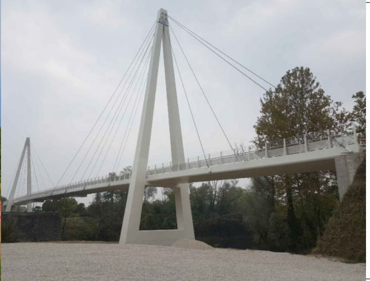
PASSERELLA STRALLATA SUL BRENTA
