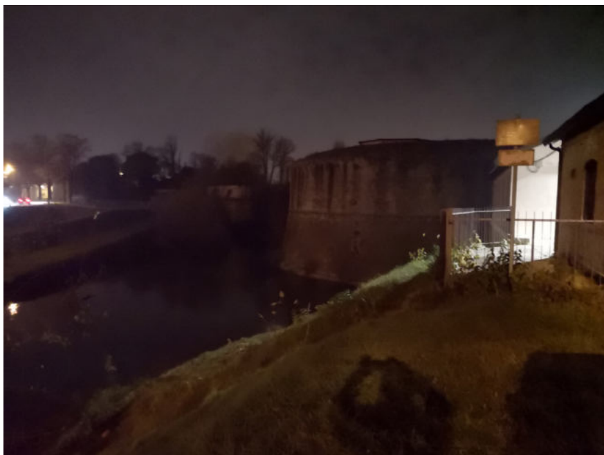
Fig. 13 – < 7. – Vista notturna attuale del potenzialmente bellissimo scorcio paesaggistico del ponte delle Gradelle di S. Massimo, con il torrione Buovo, recentemente restaurato. L’atmosfera di una Padova antica che sembra rimandare a Giorgione (la Tempesta ), oggi totalmente all’oscuro. Sempre al buio, il grande volume cilindrico del torrione, la saracinesca storica e la confluenza dei canali. A destra le Mura continuano sommerse dall’oscurità (fotografia successiva). Un’altra occasione mortificata. Paradossalmente, in grande spicco visivo il casotto della Società che gestisce l’impianto: vi si può notare - al solito, come per tutti gli 11km delle Mura - una inaudita recinzione, la viva colorazione e illuminazione, le superflue e invasive segnaletiche. (cfr. Galileo n. 268 numero speciale I canali di Padova , pg.58, op. cit.)
