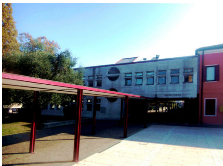
Fig. 8 - Ripresa della pensilina della piazza verso portico
