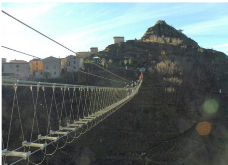
Fig. 7. Il ponte Petracca a Sasso di Castalda (Basilicata)
