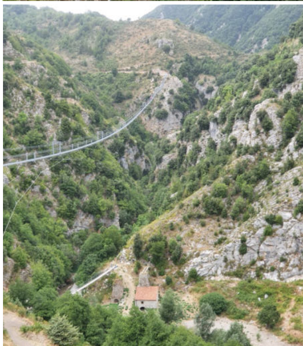
Fig. 4. Il ponte di Castelsaraceno (Basilicata)
