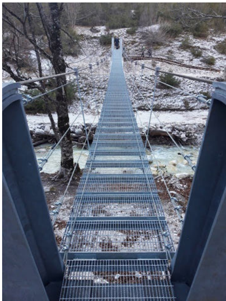
Fig. 22. Il ponte in Val Fondillo (Abruzzo)
