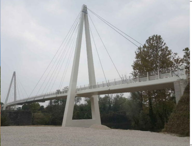
PASSERELLA STRALLATA SUL BRENTA
