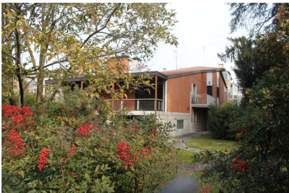
Figg. 14-15 – Prospetti Ovest e Sud dell’ampliamento, visti dal giardino
