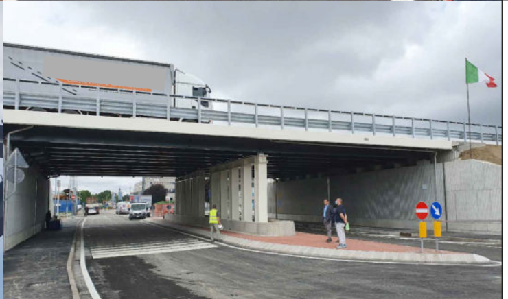
VIADOTTO TANGENZIALE EST PADOVA
