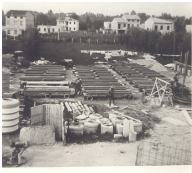
Fig.4 - Manufatti in calcestruzzo
